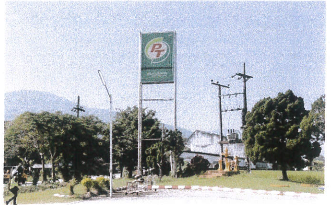
สถานีบริการที่ตรวจสอบ
